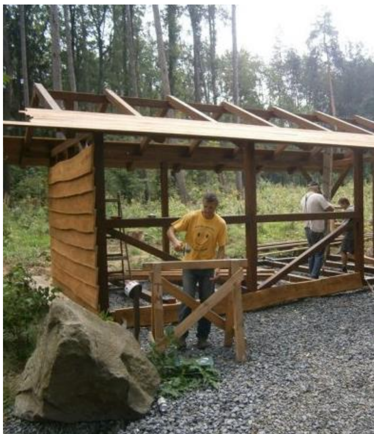
Obr.2 – Obložení dřevěnými prkny
